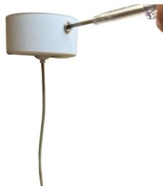
**5.** Instale o aplique no suporte através dos parafusos laterais.
